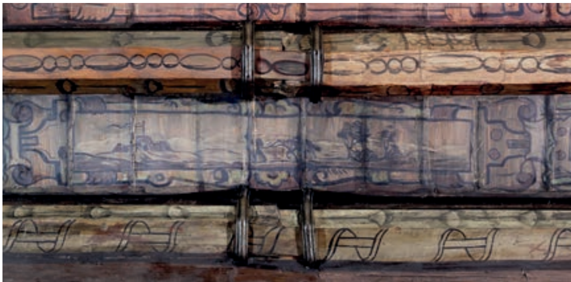
Il. 91. Zamaskowane połączenia wtórnych belek
