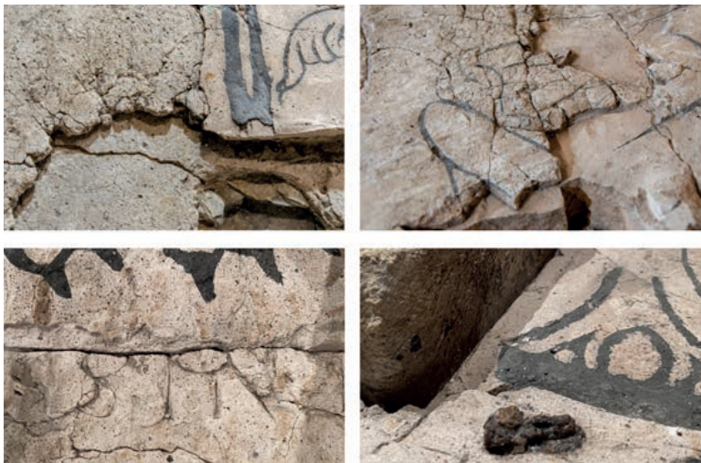
Fot. 22–25. Detale ukazujące fragmenty brzegów oraz granic poszczególnych warstw i faz tworzenia posadzki, a także ubytki powstałe w tych obszarach. Stan po zakończeniu prac, 2021, fot. M. Stec
