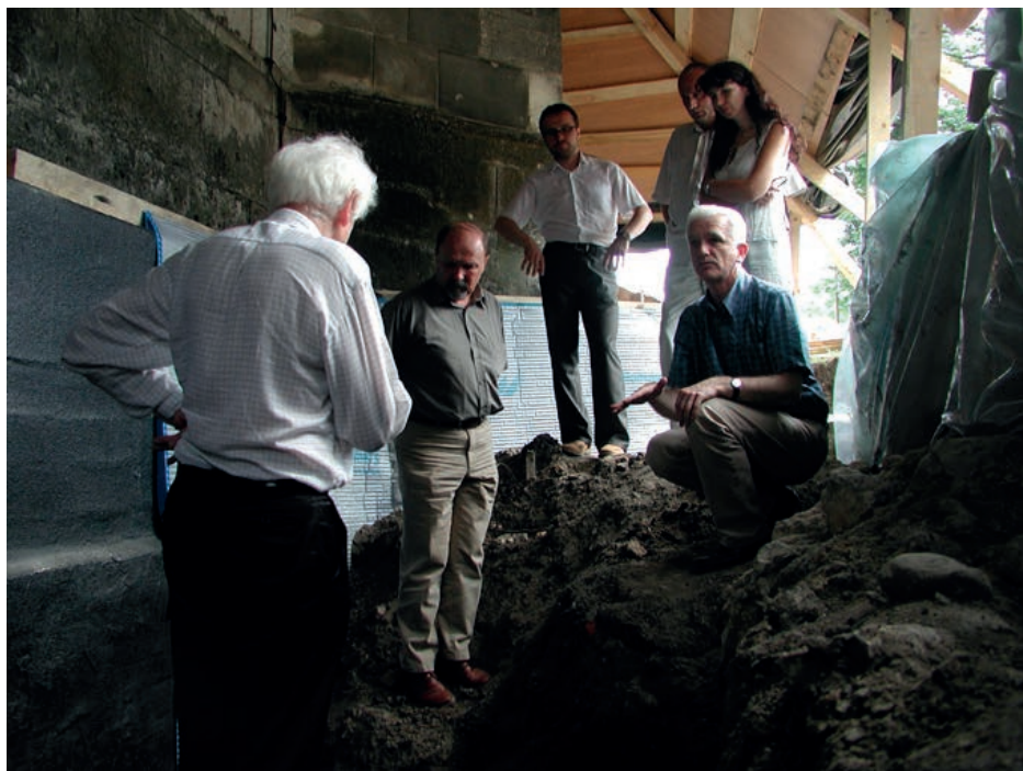
Il. 8. Komisja konserwatorska w miejscu zakładania izolacji pionowej, przy południowo-wschodnim narożniku kolegiaty, 2003, fot. M. Stec
