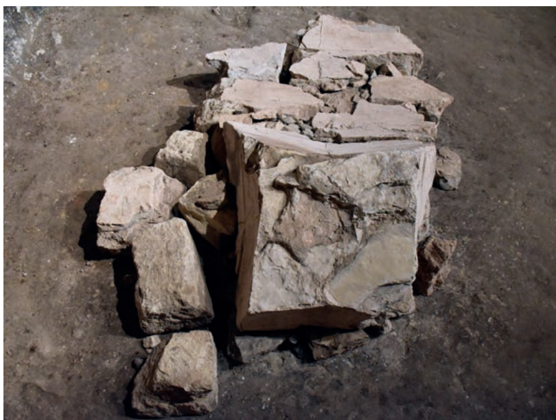
Fot. 16. Fragment sklepienia krypty znaleziony w jej wnętrzu i eksponowany w głębi prezbiterium. Fotografia ukazuje część, która spoczywała na kolumnie. Widoczne także odciski desek szalunkowych, 2023, fot. M. Godek
