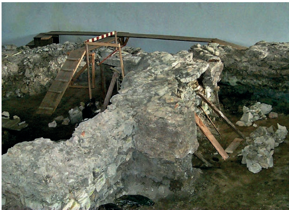
Il. 9. Kościół św. Mikołaja podczas stabilizacji muru zewnętrznego oraz południowo-wschodniej absydy, 2000, fot. M. Stec
